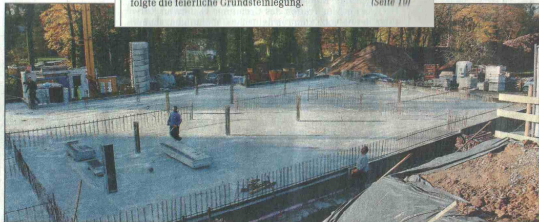
So sieht die Baustelle im unteren Teil des Schlossparks derzeit aus.
