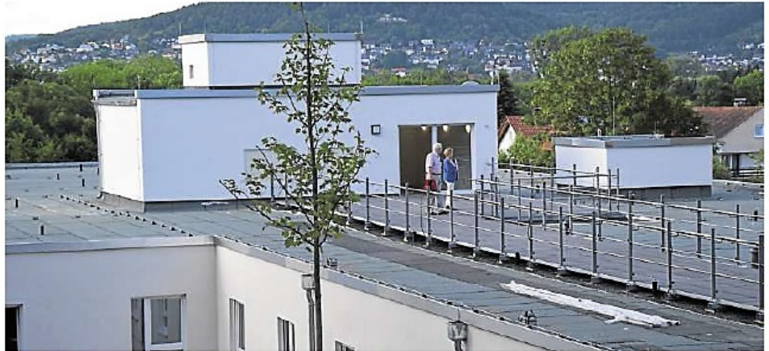
Ein Fußweg über die Dachterrasse ermöglicht den direkten Zugang zum Schloss.
